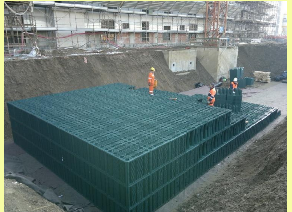
trincee drenanti a moduli prefabbricati
