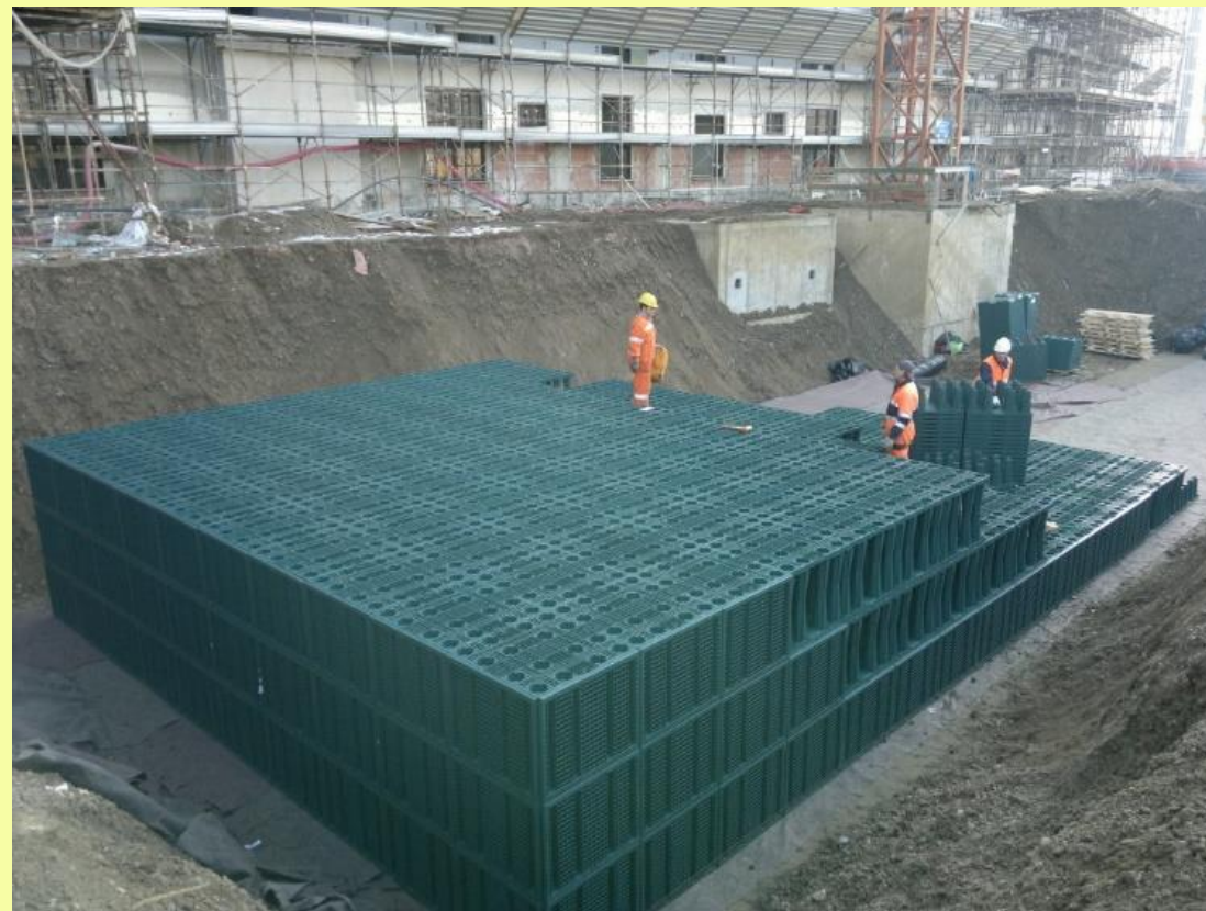
trincee drenanti a moduli prefabbricati
